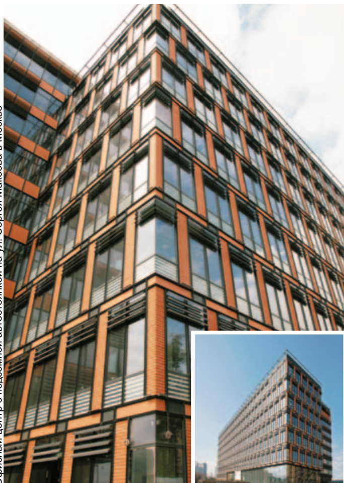
Офисный центр с подземной автостоянкой на ул. Сергея Макеева в Москве
