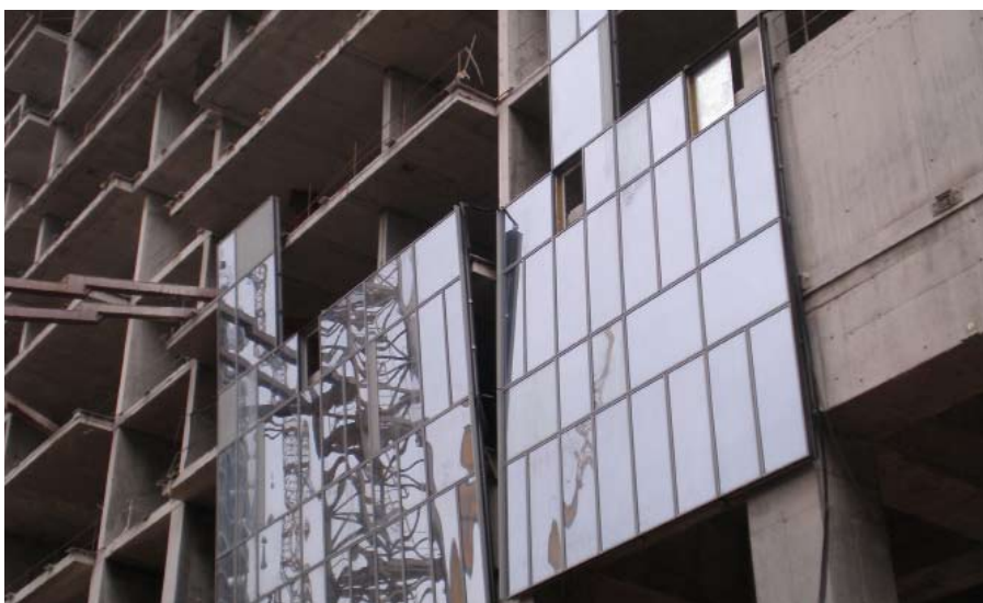
Вверху. Огневые испытания навесных панелей объекта на ул. С. Макеева, Москва Внизу. Монтаж панелей для жилого комплекса на ул. Пырьева, Москва
